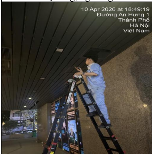
KT đấu nối lắp lại các bóng đèn khu vực vui chơi tầng 1 V1
